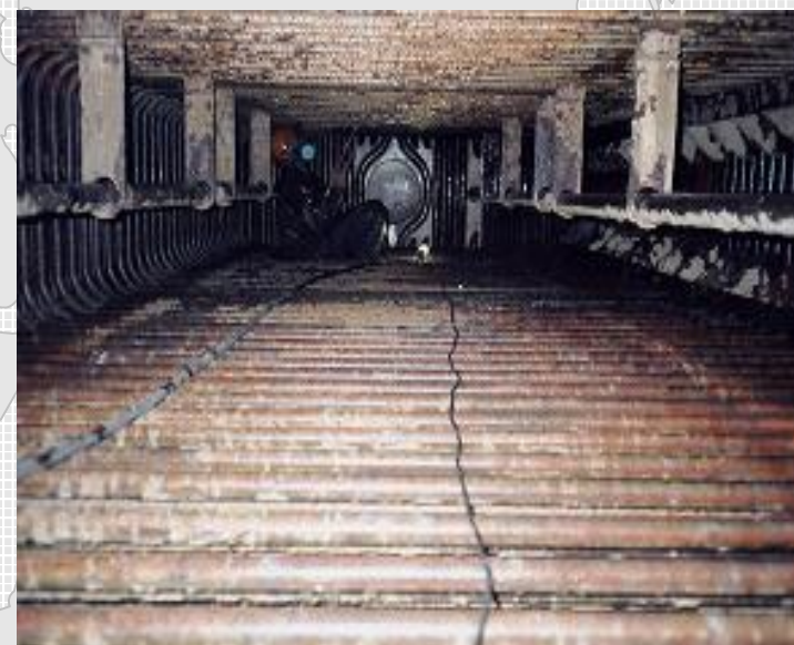
高圧洗浄工法作業中
