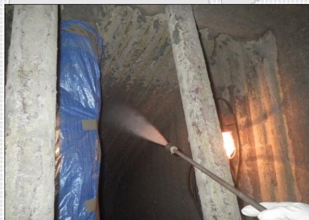
ボイラ水管壁洗浄
