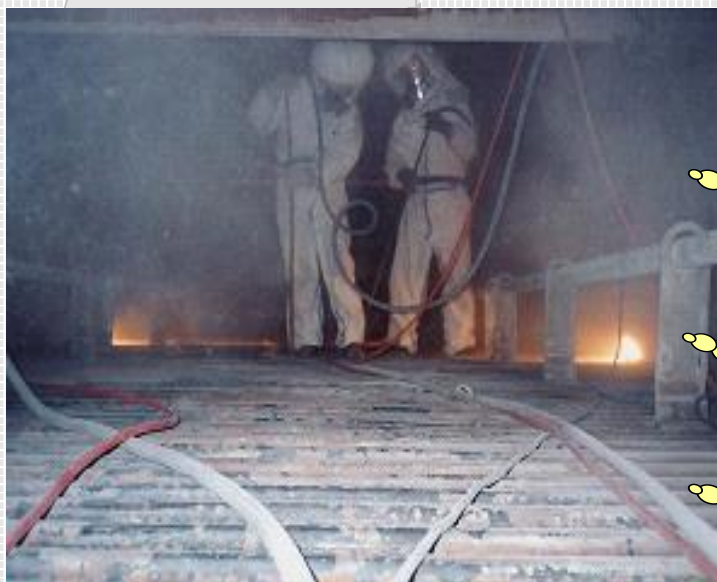
乾式工法作業中
