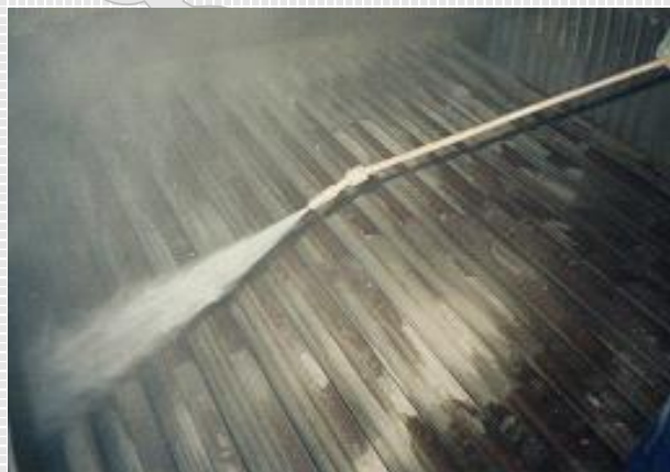
ボイラ管群洗浄
